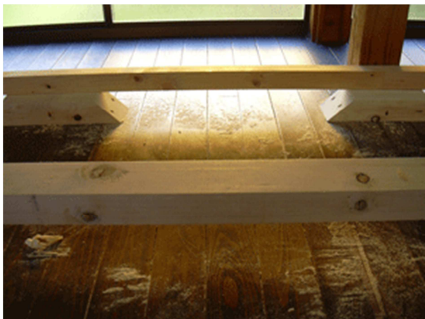
③元の床板の上にクッションをつけて張ります。
