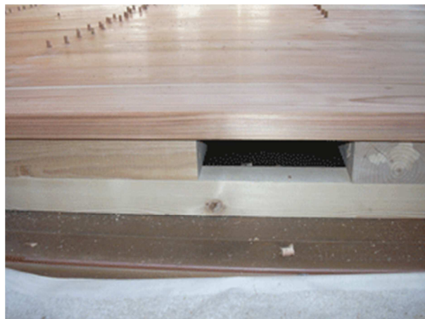
④ 張り始めです
