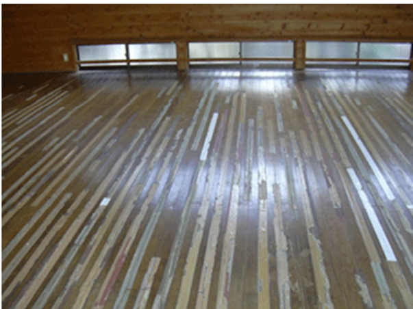
① 激しい稽古で補修だらけの床 ガムテープで補修していました。
